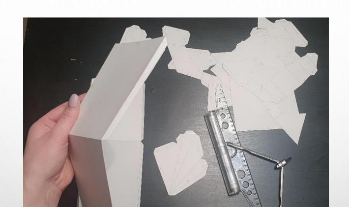
3. СЛЕДУЮЩИЙ ШАГ-БИГОВКА ВСЕХ ВНУТРЕННИХ ЛИНИЙ И СГИБ ПО НИМ. С ПОМОЩЬЮ ИГЛЫ ОТ ЦИРКУЛЯ ПРОДАВИТЬ ВСЕ ЛИНИИ ПО ЛИНЕЙКЕ. НЕЛЬЗЯ СИЛЬНО НАДАВЛИВАТЬ НА ИГЛУ, ЧТОБЫ НЕ ОБРАЗОВАЛИСЬ ДЫРЫ. РАБОТЫ ПО БИГОВКЕ НУЖНО ПРОВОДИТЬ НА ПОДЛОЖКЕ, ЧТОБЫ НЕ ПОВРЕДИТЬ ПОВЕРХНОСТЬ СТОЛА.
